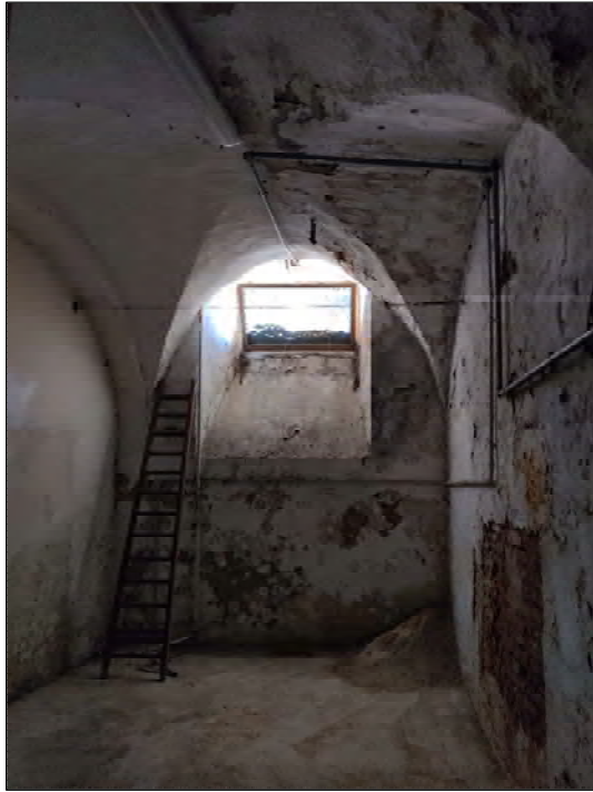
Volte di copertura del piano seminterrato e del piano terra
