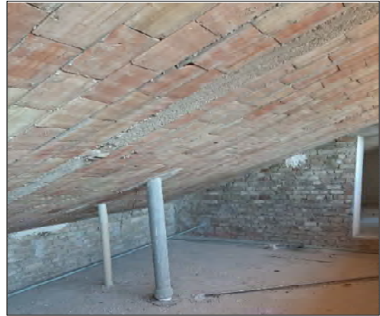
Falde in latero-cemento della copertura
