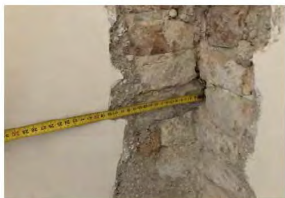
Piano secondo – esempi di muratura portante
