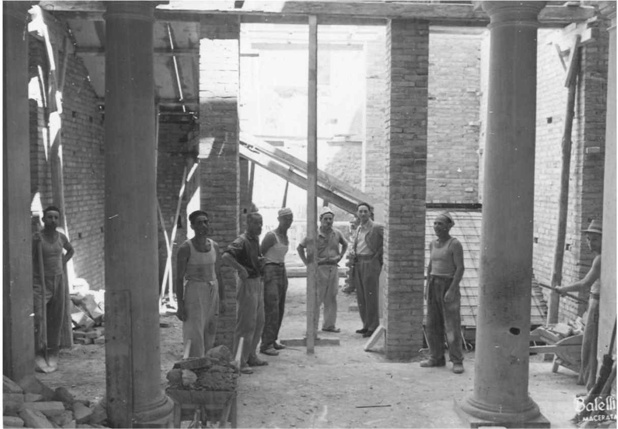
Figura 21 – Cantiere di ristrutturazione dell'ingresso con realizzazione del vano scala (sullo sfondo)
