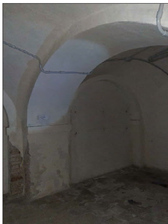
Volte di copertura del piano seminterrato
