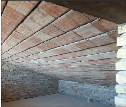
Falde in latero-cemento della copertura
