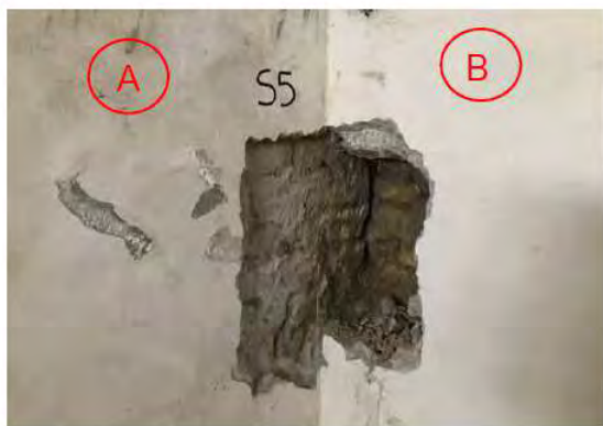
Piano terra – esempi di muratura portante
