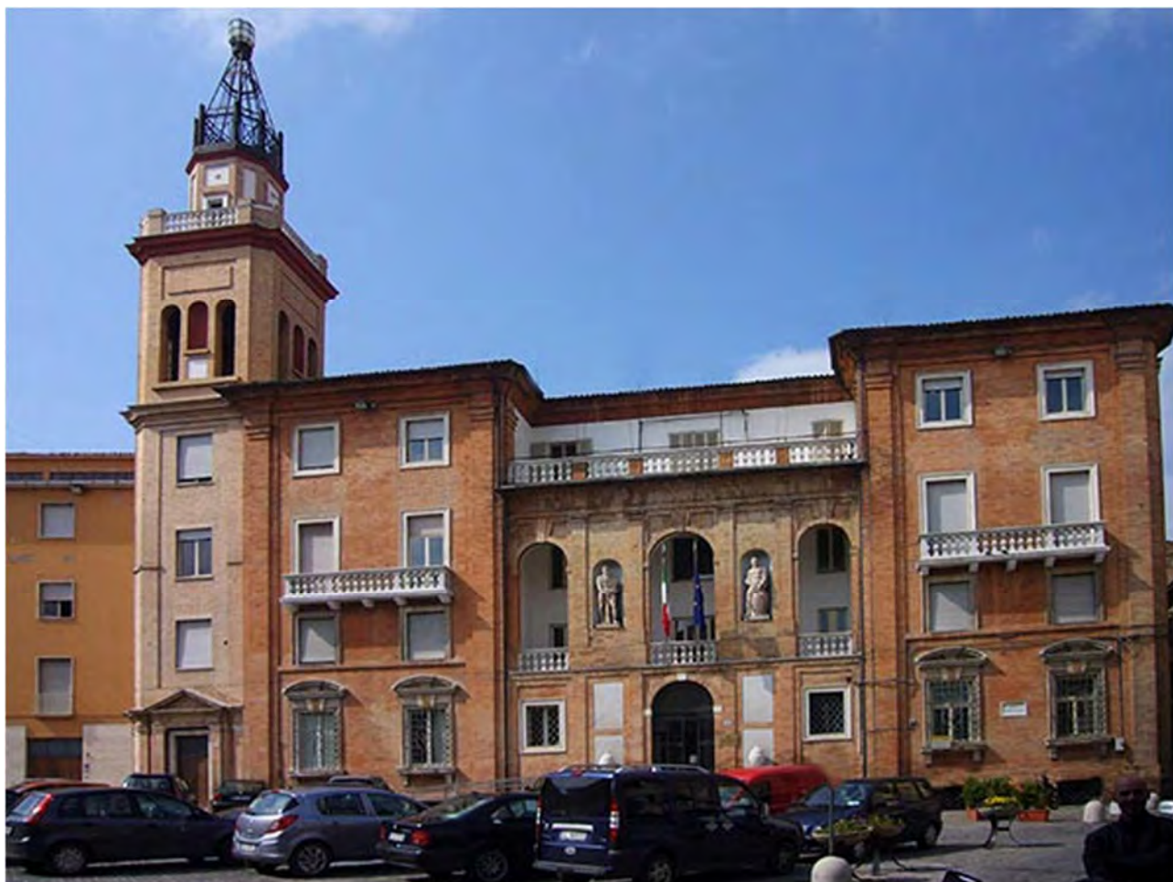
Figura 25 - Casa del Fascio dopo le modifiche del 1956
