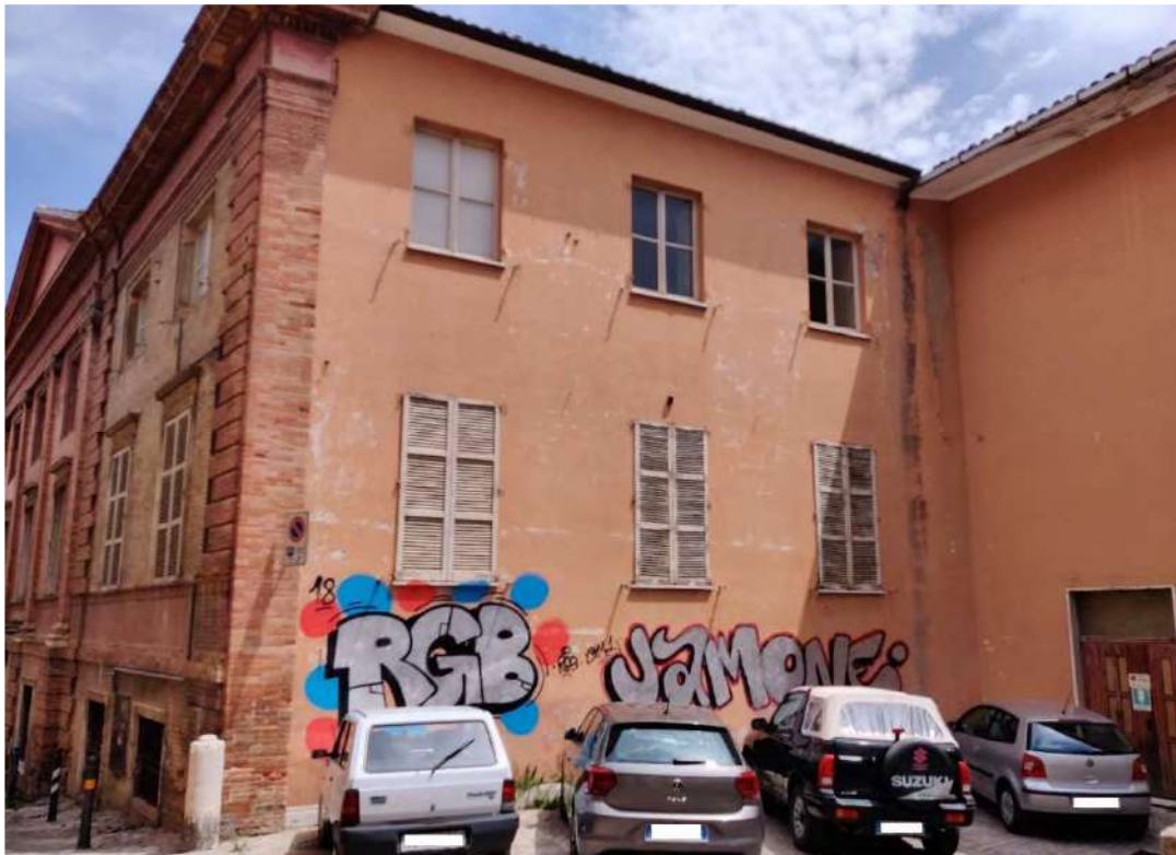
Facciata Ovest (a)
