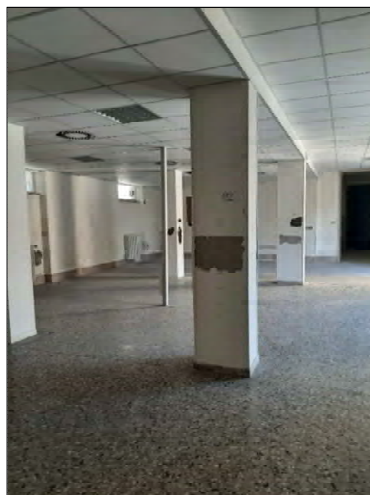
Pilastri e travi in calcestruzzo armato
