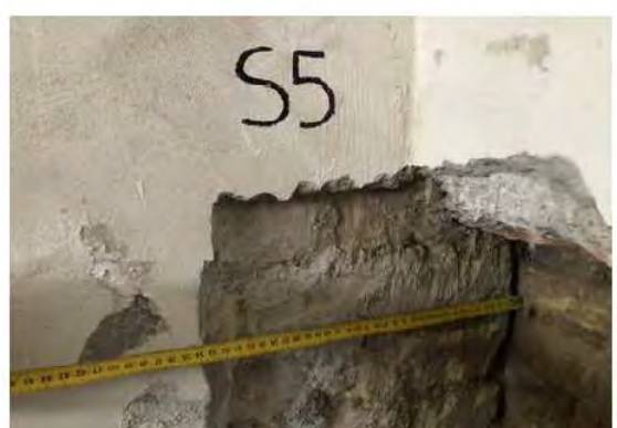
Piano terra – esempi di muratura portante
