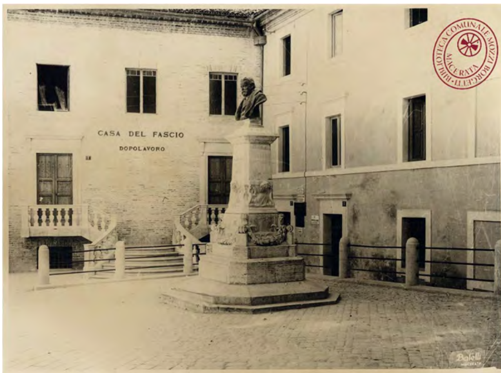
Figura 4 - Ingresso del Teatro Littorio, vista da Piazza Lauro Rossi (1924)
