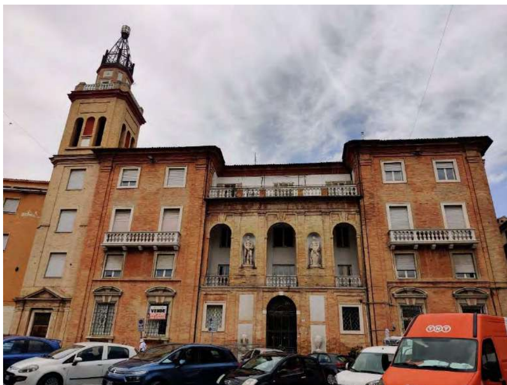
Facciata Sud (b)
