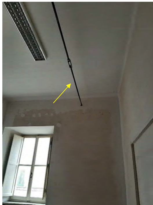
Alcuni tiranti in acciaio rilevati su primo piano e secondo piano
