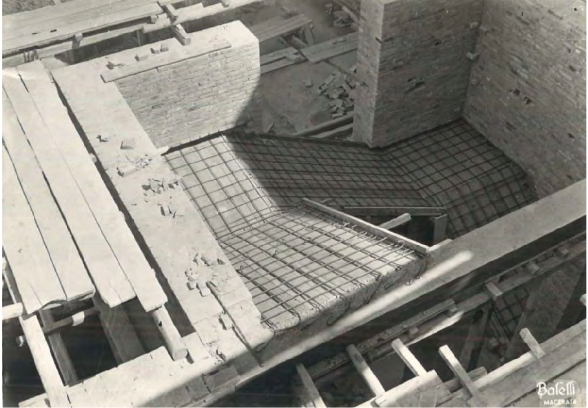
Figura 23 - Realizzazione scala
