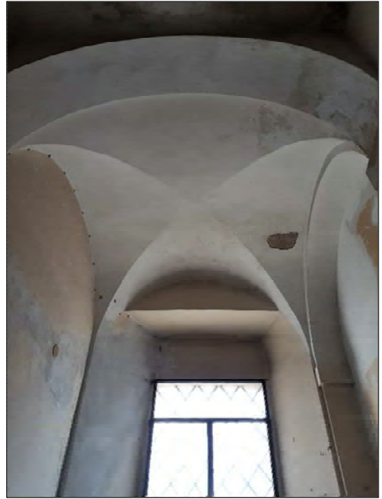
Volte di copertura del piano seminterrato e del piano terra
