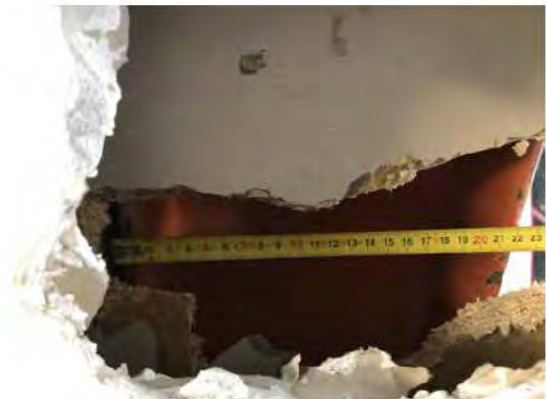
Piano primo – profilati metallici (Fabbricato laterale)
