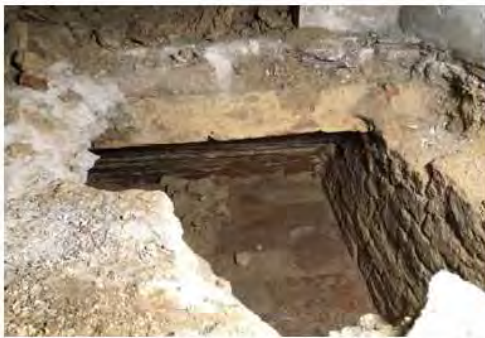
Solaio in cls e volta in mattoni sottostante
