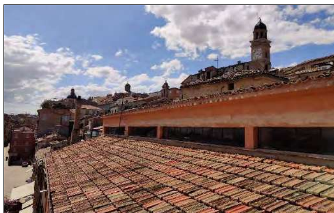
Copertura in latero - cemento
