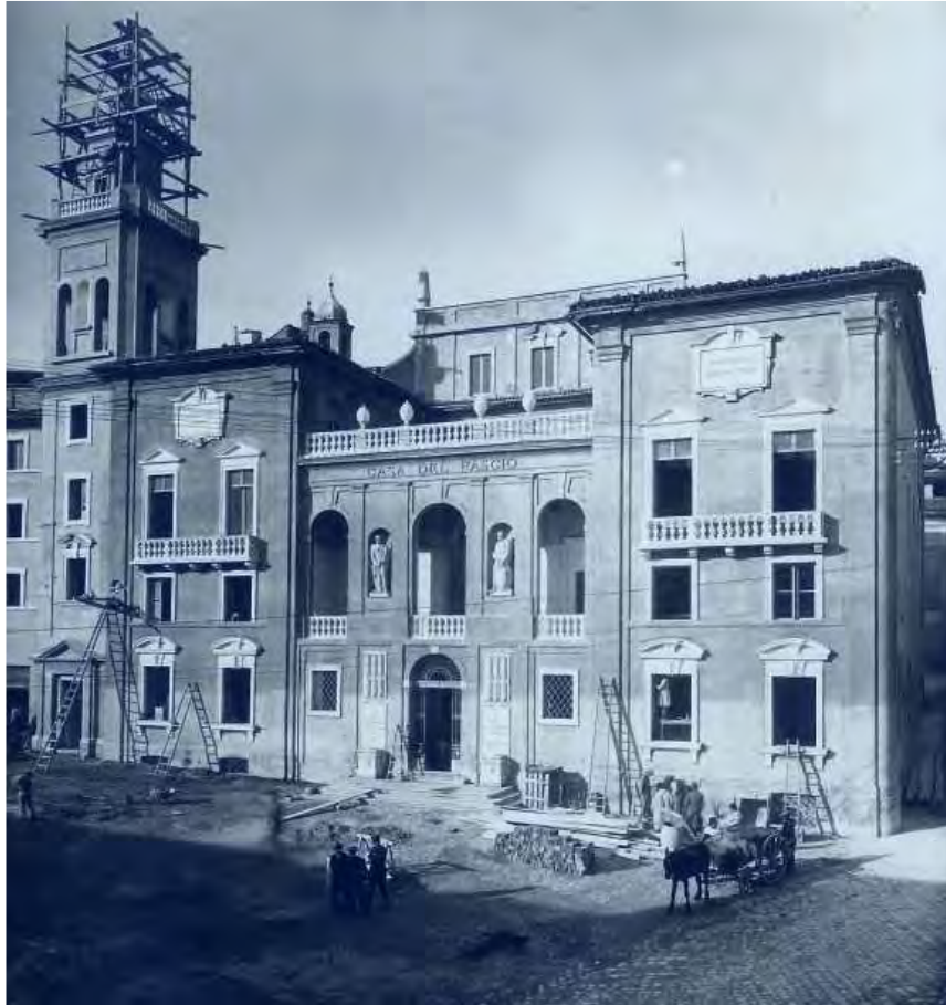
Figura 6 - Lavori di costruzione della "Casa del Fascio" (1925-1928)
