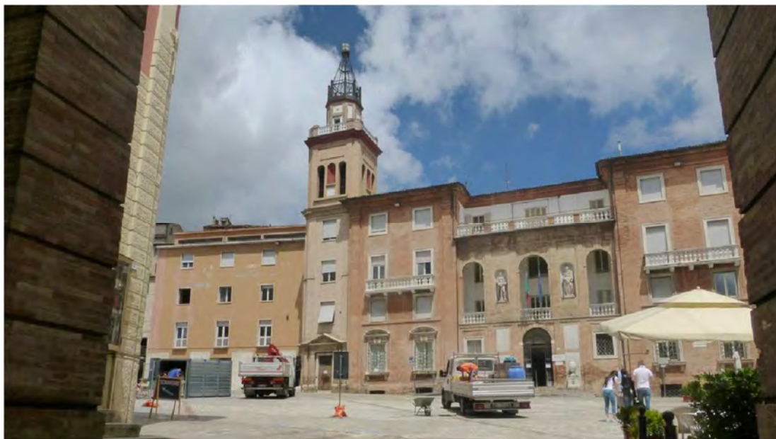
Facciata Sud (a)
