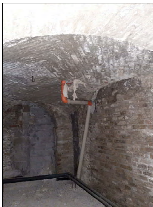
Volte di copertura del piano seminterrato
