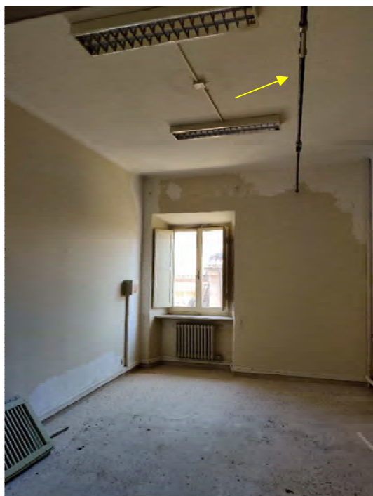
Alcuni tiranti in acciaio rilevati su terzo piano e sottotetto del Fabbricato laterale
