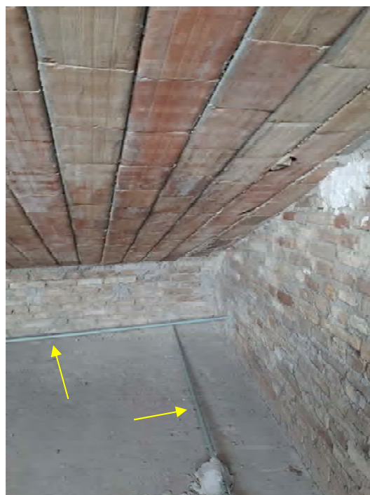
Alcuni tiranti in acciaio rilevati su terzo piano e sottotetto del Fabbricato laterale
