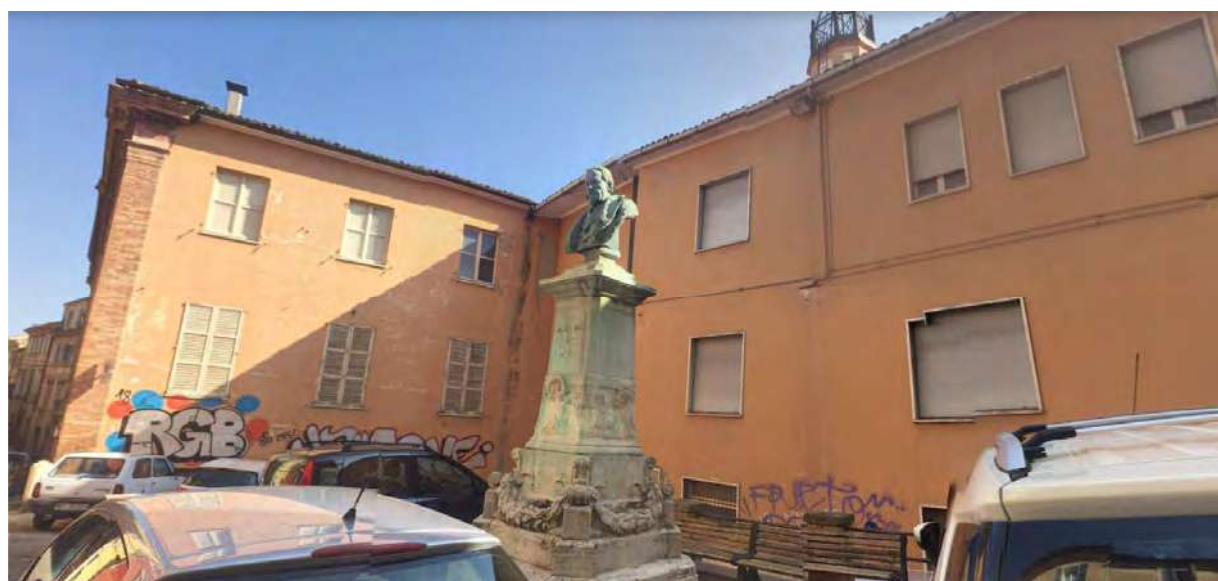
Facciata Ovest - Nord
