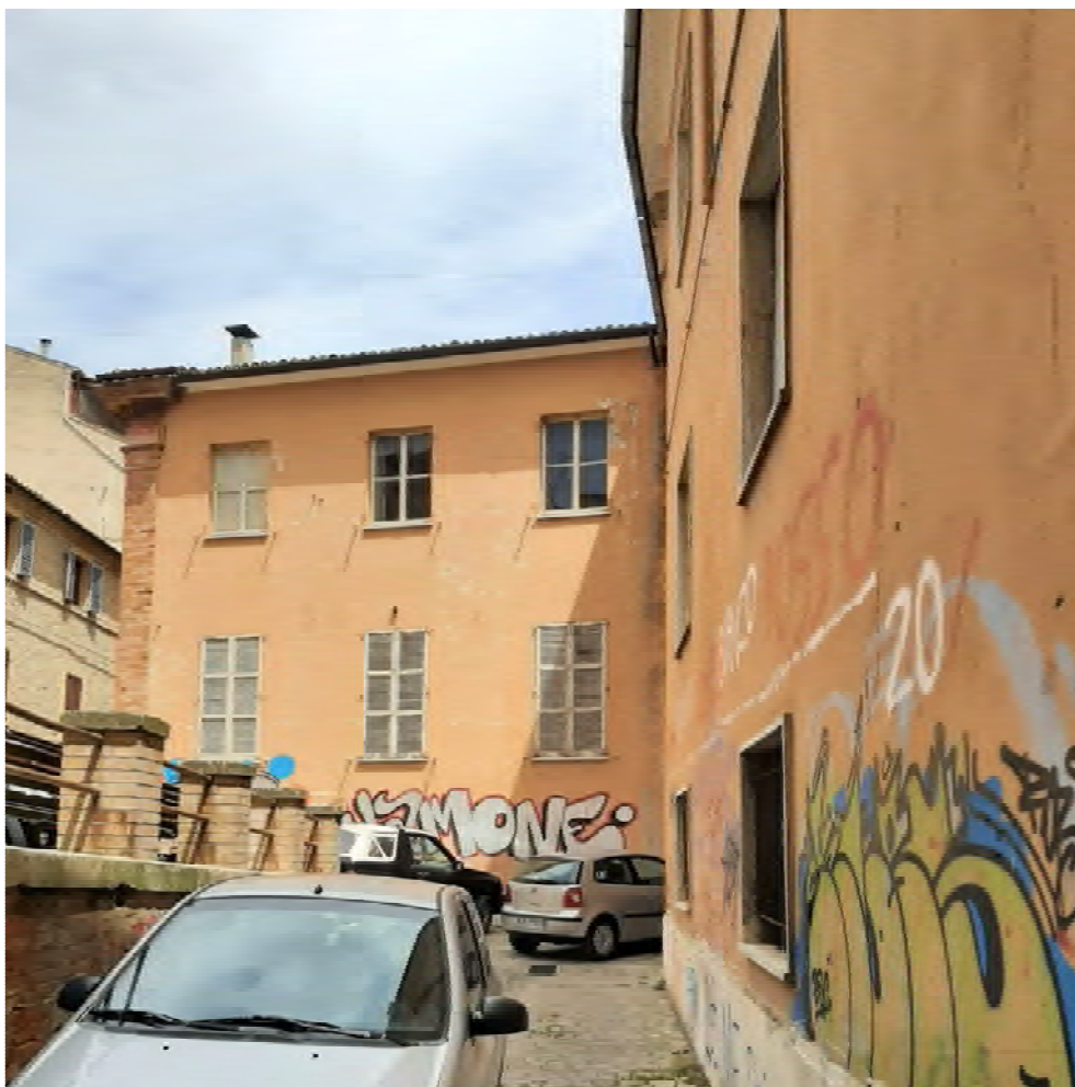
Facciata Ovest (b)
