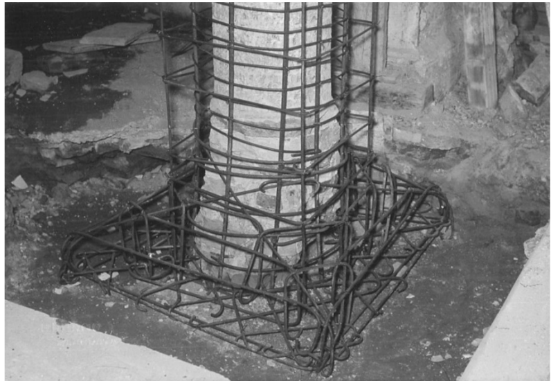
Figura 22 - Incamiciatura colonna ingresso
