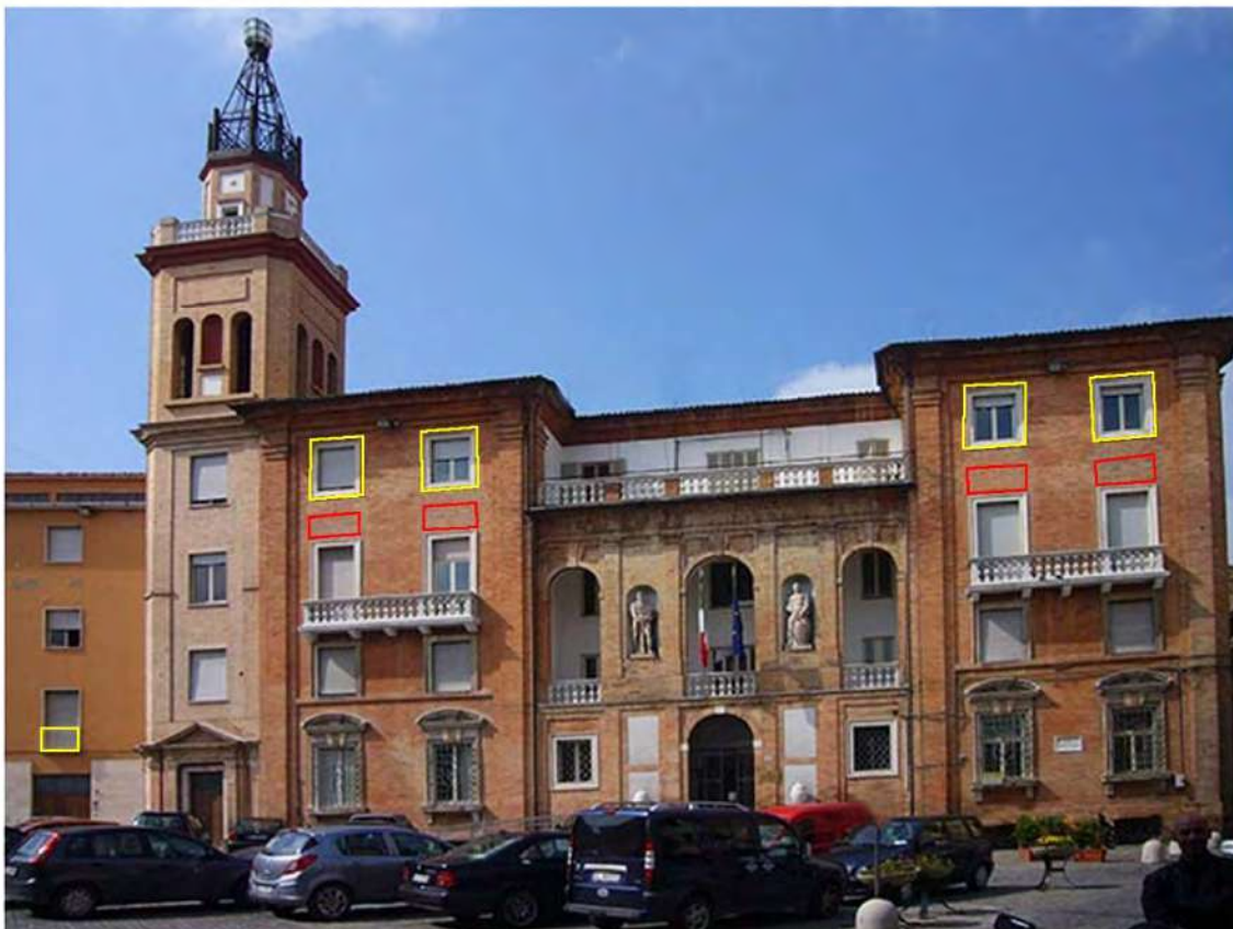
Figura 13 - Facciata lato Piazza G.Mazzini, confronto prima e dopo gli interventi di ristrutturazione del 1955
