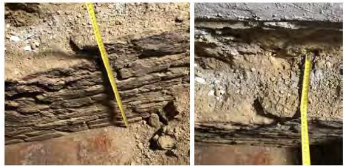
Rilievo ringrosso parete perimetrale
