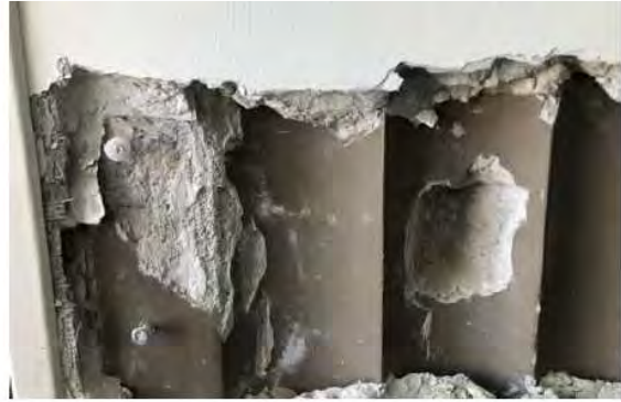
Piano terra – pilastro in muratura rivestito da porzione in calcestruzzo
