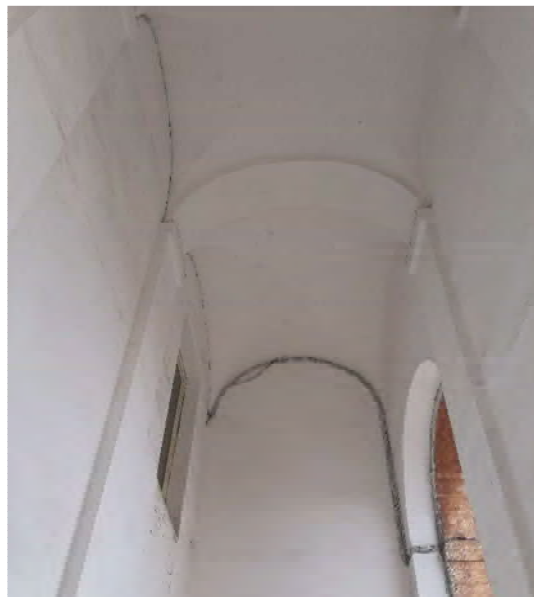
Copertura del loggiato
